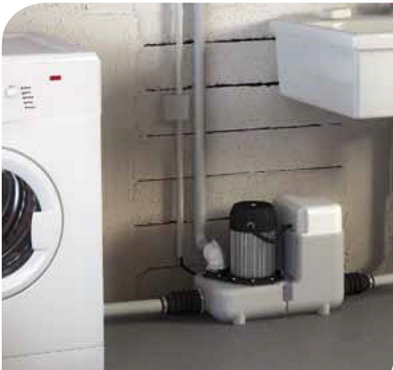
Vertikaalne ja horisontaalne äravool: ↑ 10 m → 100 m
