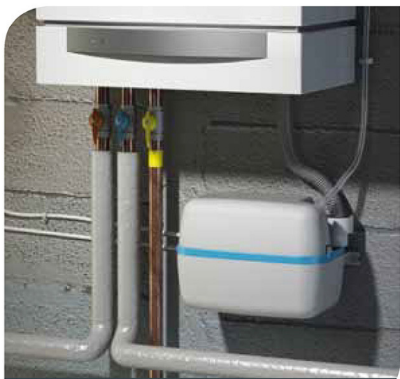
Vertikaalne ja horisontaalne äravool: ↑ 4,5 m → 50 m
