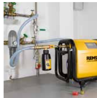
Дезинфекция сантехнического оборудования питьевого водоснабжения
