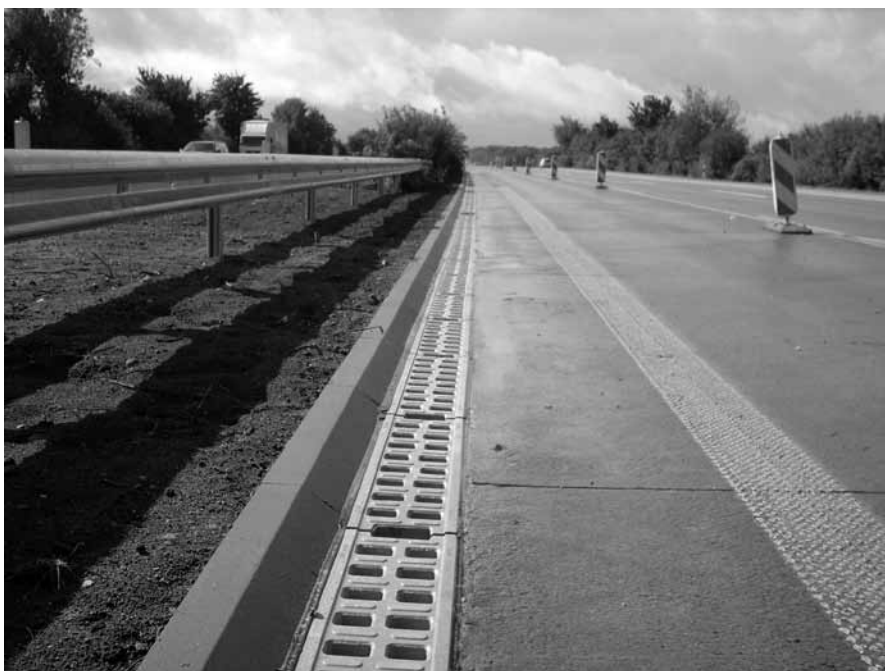
RD 200 V paigaldatuna kiirteele
